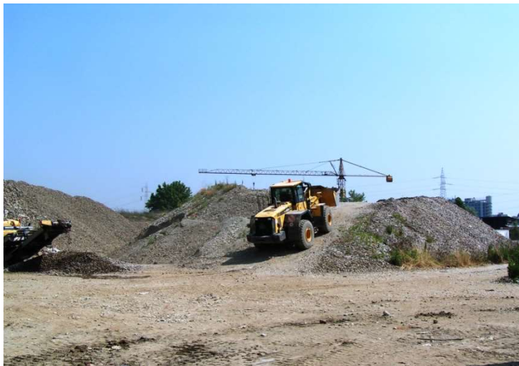
Cumulo di materiale inerte trattato
