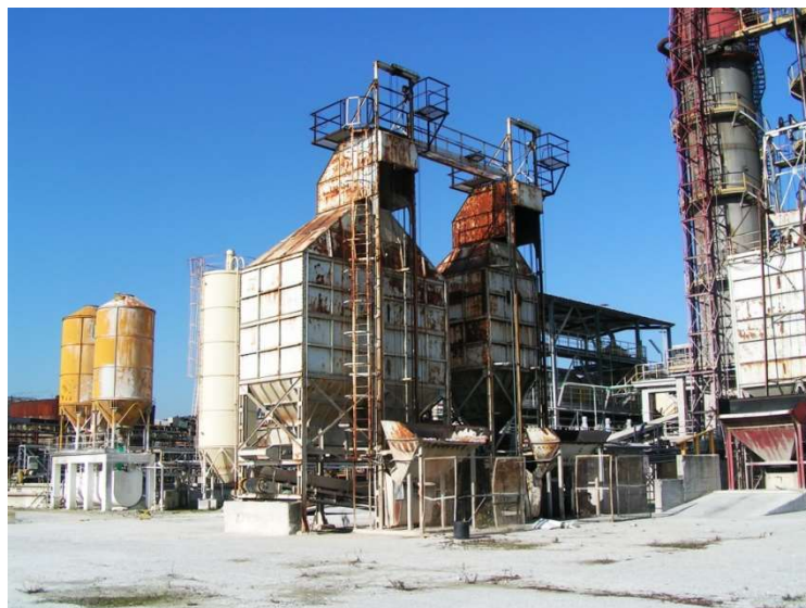
Strutture da demolire
