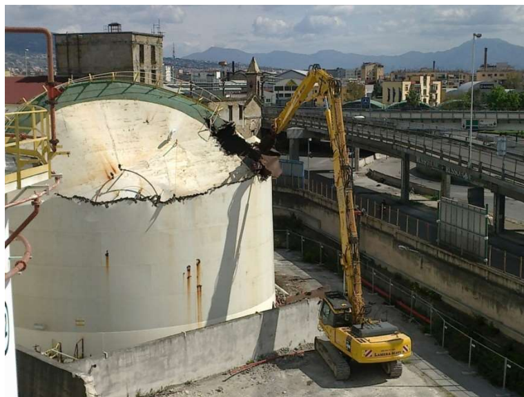
Escavatore durante la demolizione di un serbatoio
