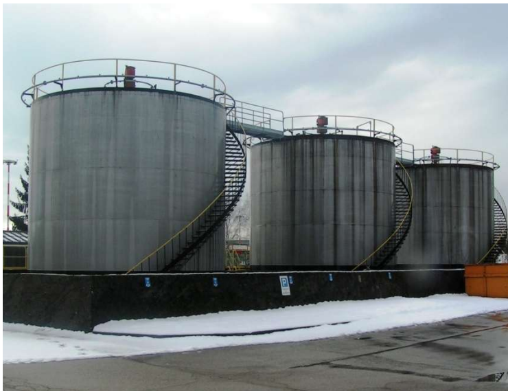
Serbatoi Jet A Fueldemolire
