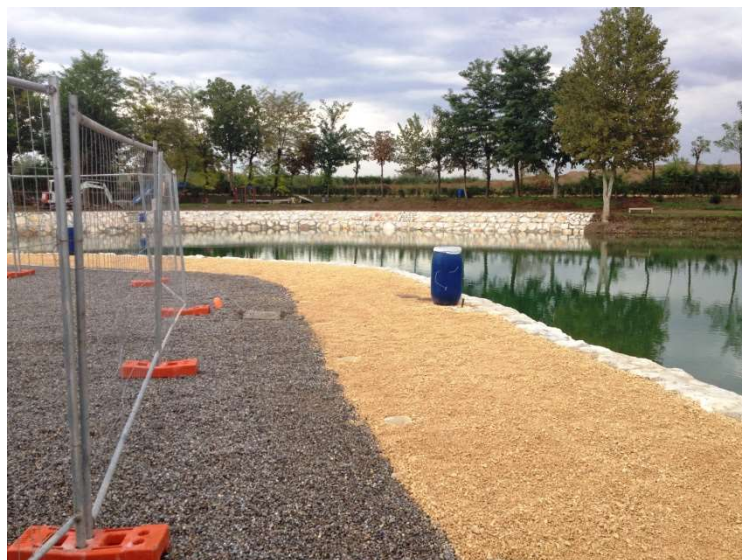
Sistemazione area esterna
