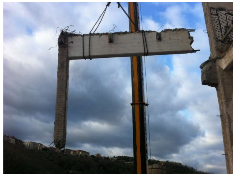
Scarico a terra di un pezzo di struttura in C.A.
