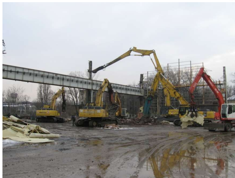
Mezzi impiegati nei lavori di demolizione
