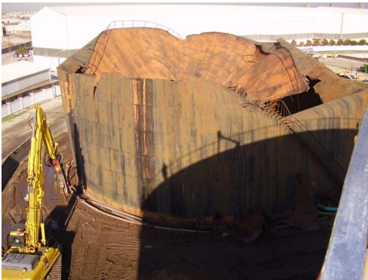
Veduta aerea dei lavori di demolizione
