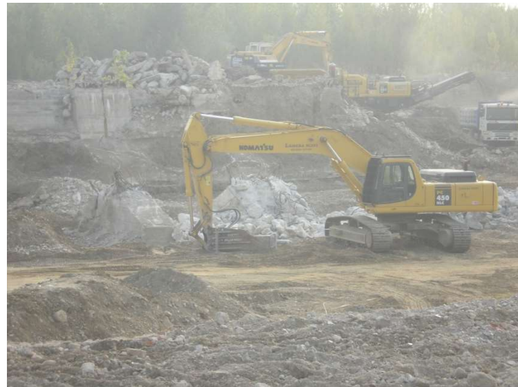
Demolizione delle strutture industriali in cemento armato
