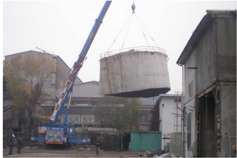
Autogrù impiegati nei lavori di demolizione
