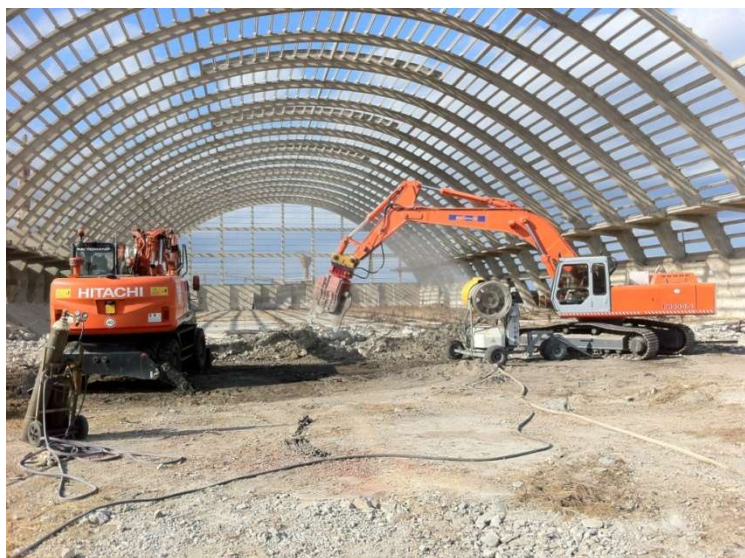
Frantumazione blocchi di cemento per successivo sgombero
