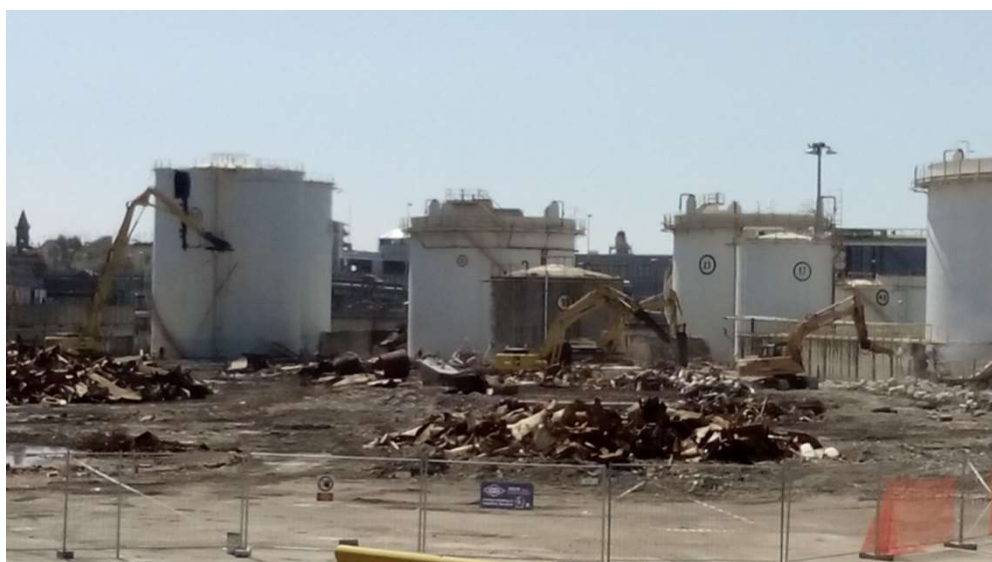
Escavatori con cesoie e pinza utilizzati durante i lavori
