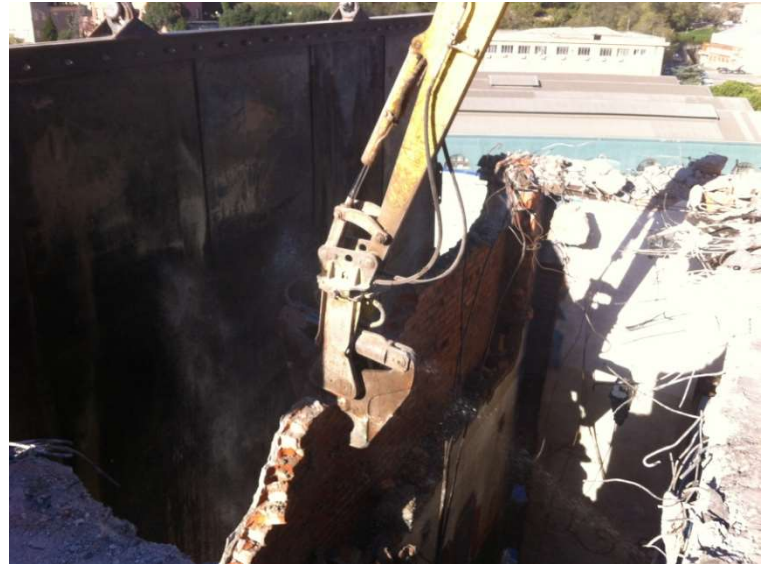
Altra veduta delle manovre effettuate per la demolizione
