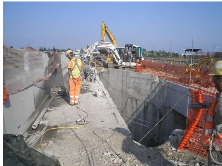
Area interessata alla demolizione
