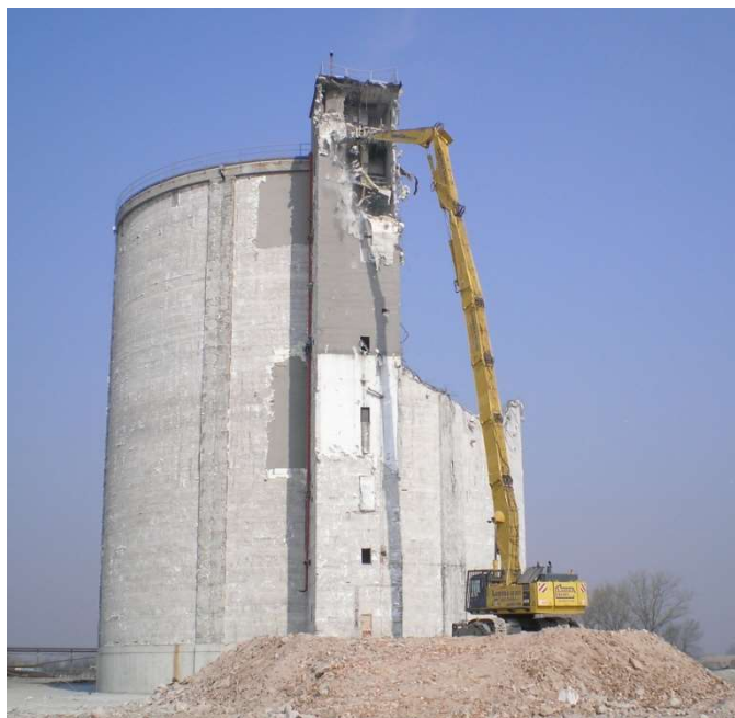
Demolizione silos in cemento armato
