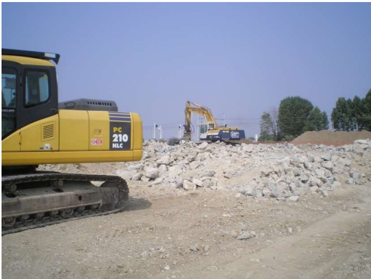
Escavatori durante i lavori
