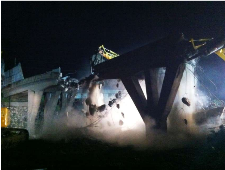
Demolizione di un cavalcavia
