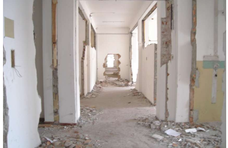
Strip out dei locali e delle strutture pre-demolizione
