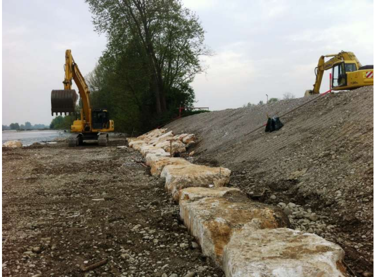
Posizionamento massi
