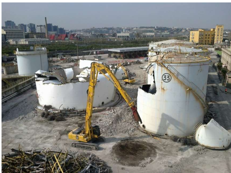
Vista aerea della demolizione di un serbatoio
