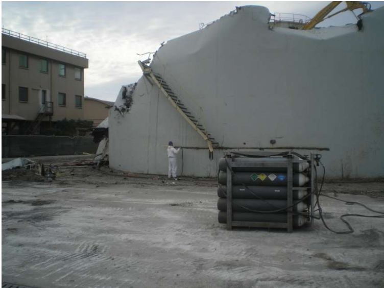
Taglio a caldo per rimuovere la base dei serbatoi
