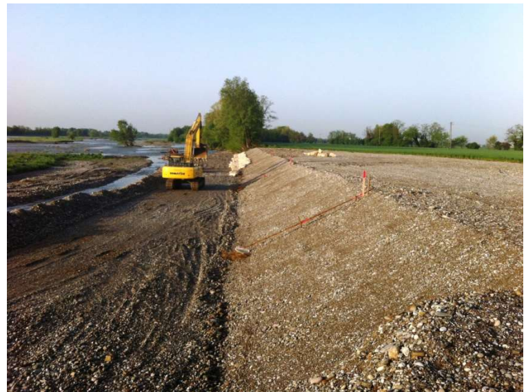
Escavatori in azione
