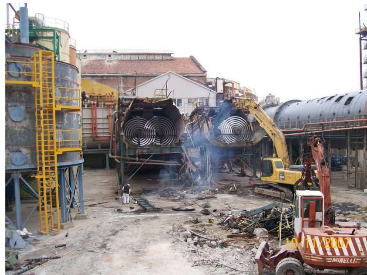
Escavatori cingolati con cesoia idraulica
