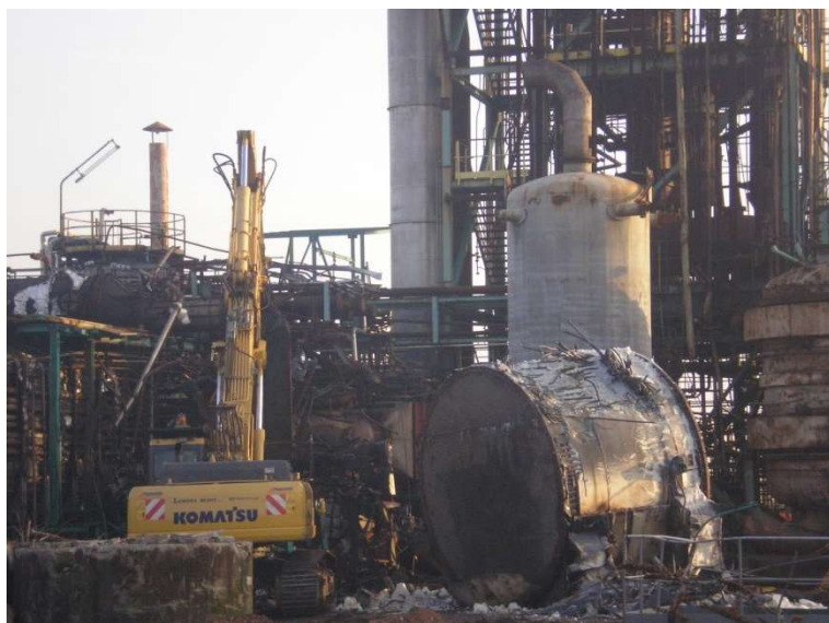
Escavatore durante le demolizioni
