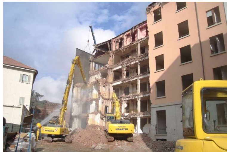
Demolizione padiglione tramite escavatore
