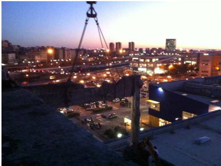
Imbragaggi mediante autogru
