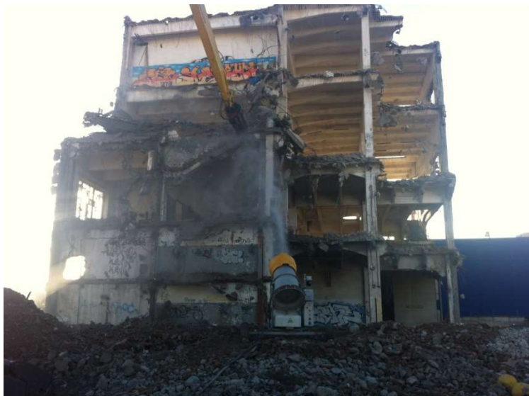
Utilizzo del cannone abbatti polvere
