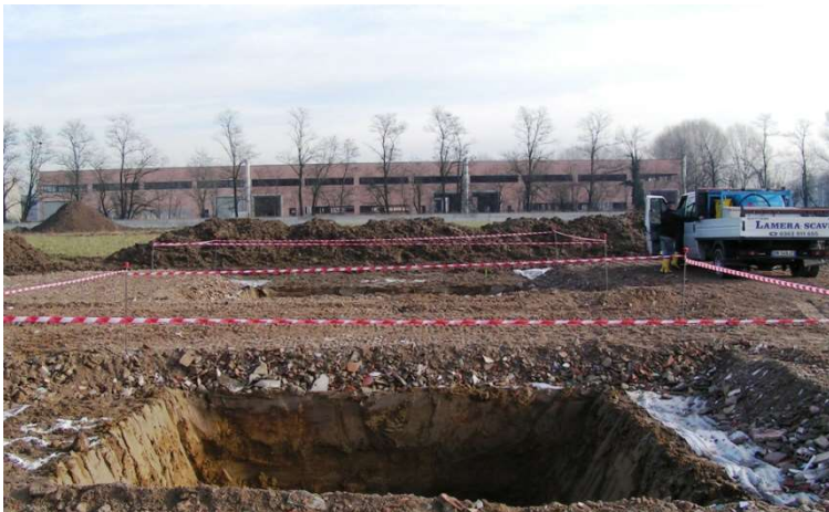
Scavi in sezione per plinti
