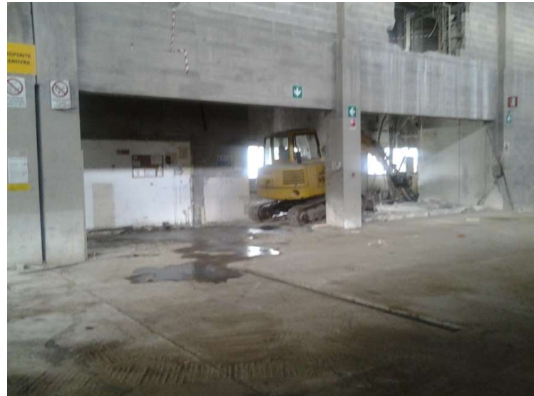
Demolizione strutture aeree e tubazioni attrezzature industriali
