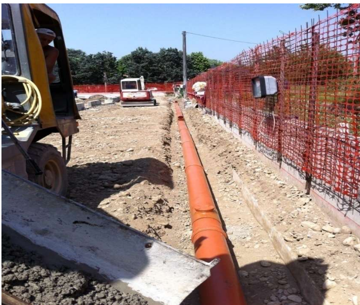
Posa di tubazioni in pvc
