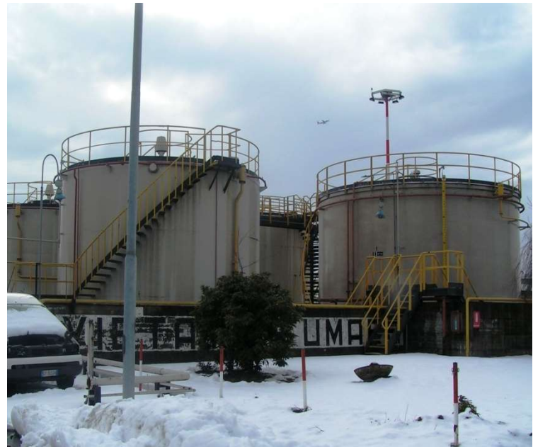
Serbatoi Jet A Fueldemolire
