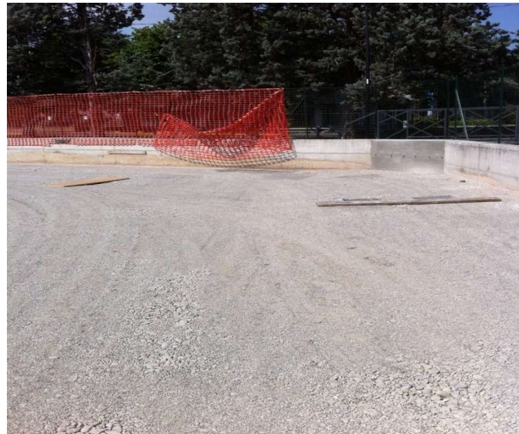
Formazione di sottofondo con mistone da cava
