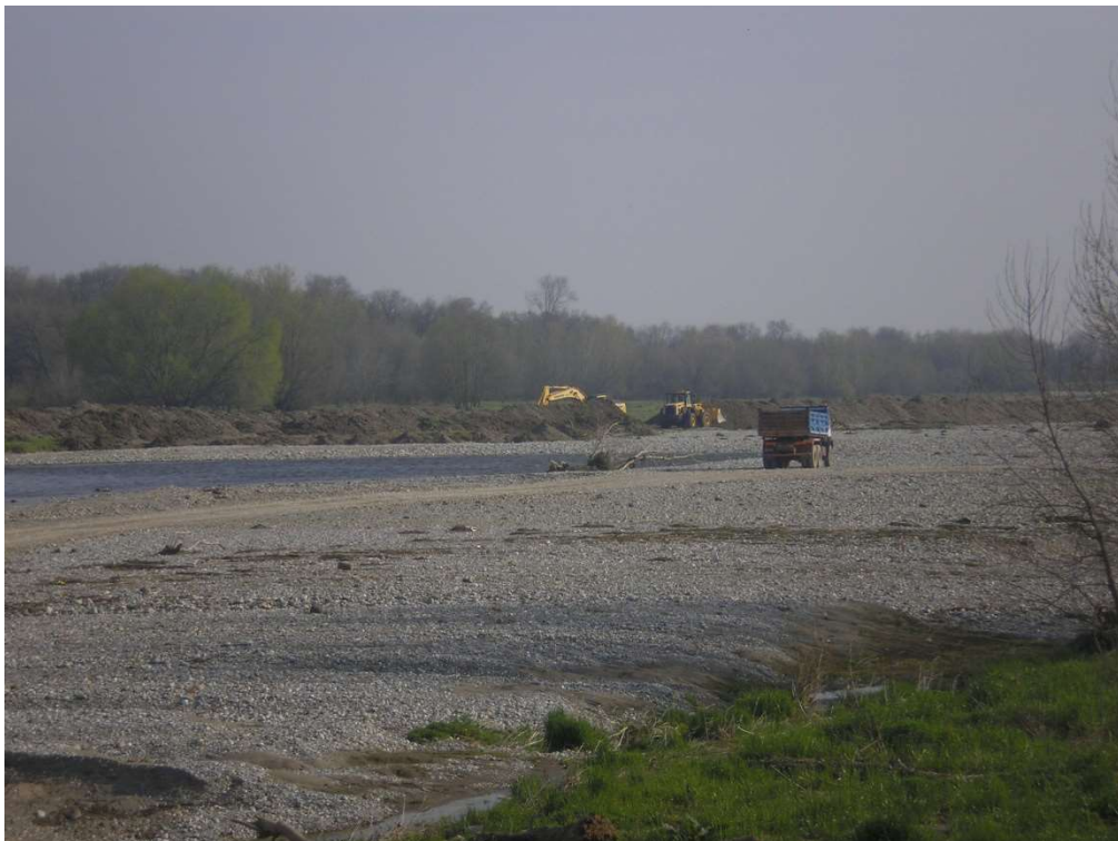
Autocarro, pala gommata ed escavatore durante i lavori
