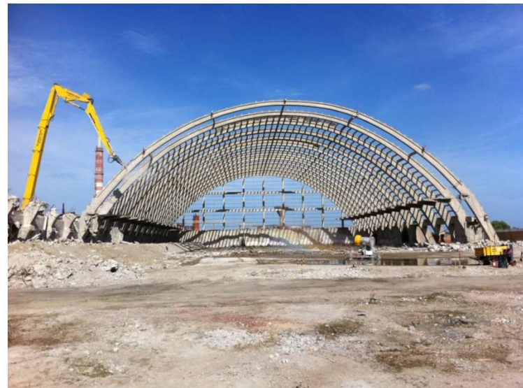
Veduta del cantiere durante le attività di demolizione
