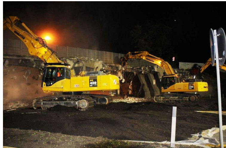
Escavatori in azione
