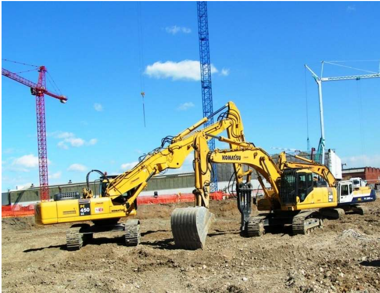
Mezzi impiegati nei lavori di demolizione
