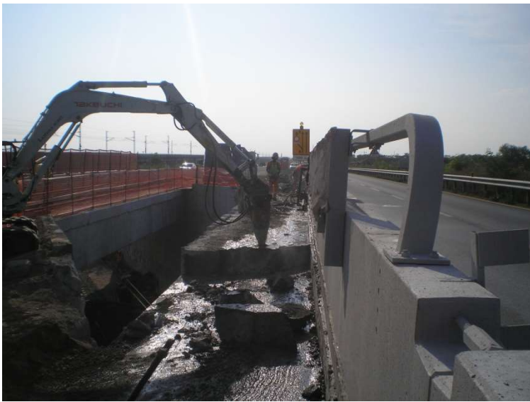
Demolizione del ponte
