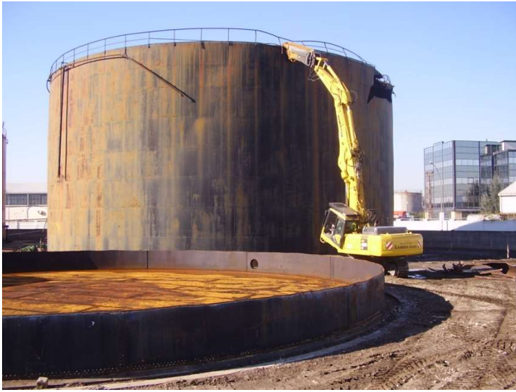
Demolizione strutture in ferro
