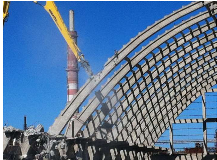
Frantumazione struttura in c.a.
