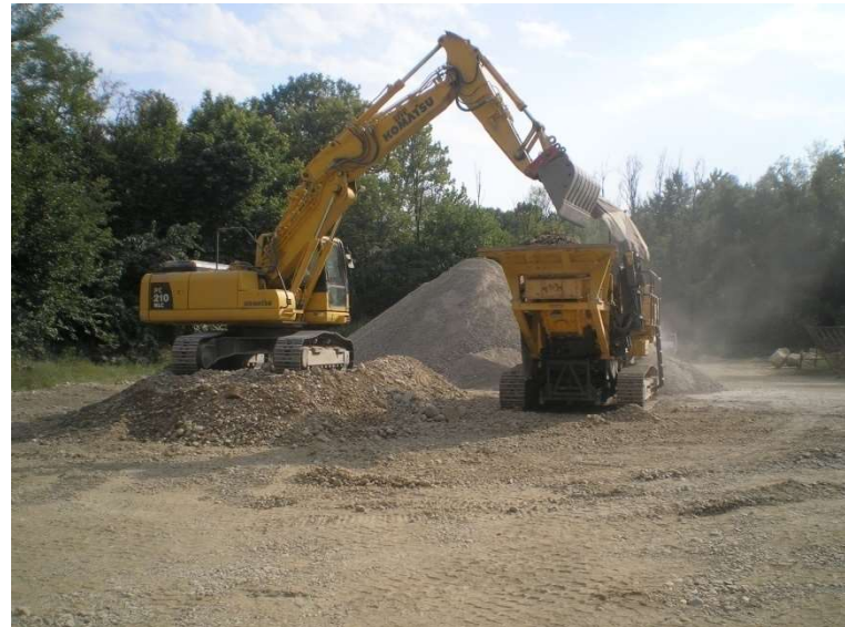
Escavatore per carico tramoggia
