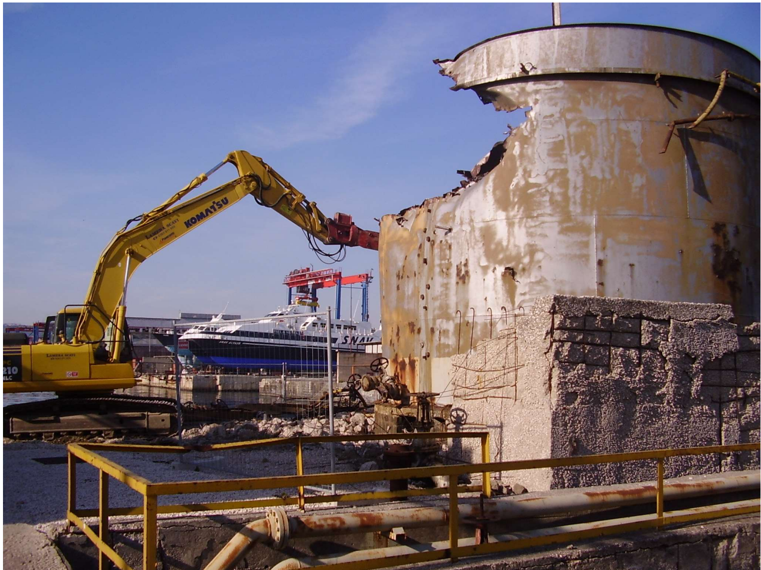
Demolizione silos con cesoia idraulica
