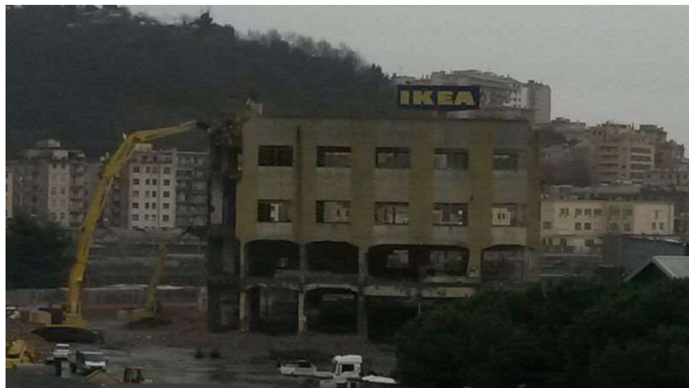
Demolizione dell'edificio ex mensa
