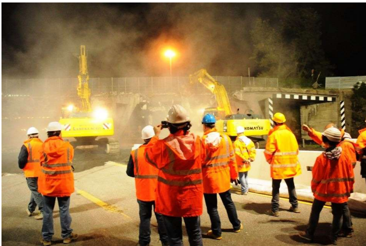
Durante la fase di demolizione
