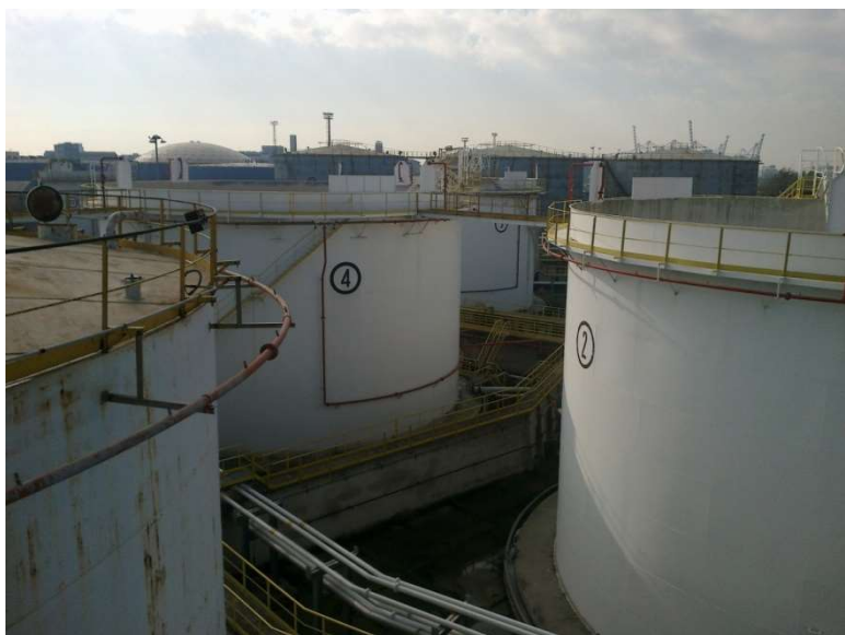
Vista aerea prima dell'intervento
