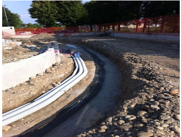
Scavi in sezione e posa polifere
