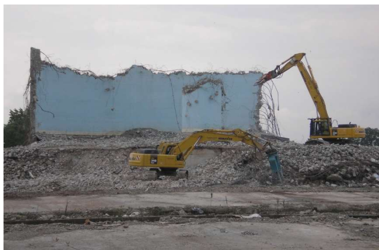
Mezzi durante le demolizioni delle strutture in cemento armato
