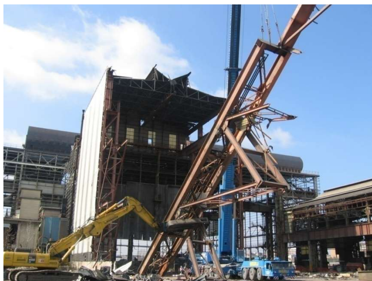
Escavatori cingolati con cesoia idraulica
