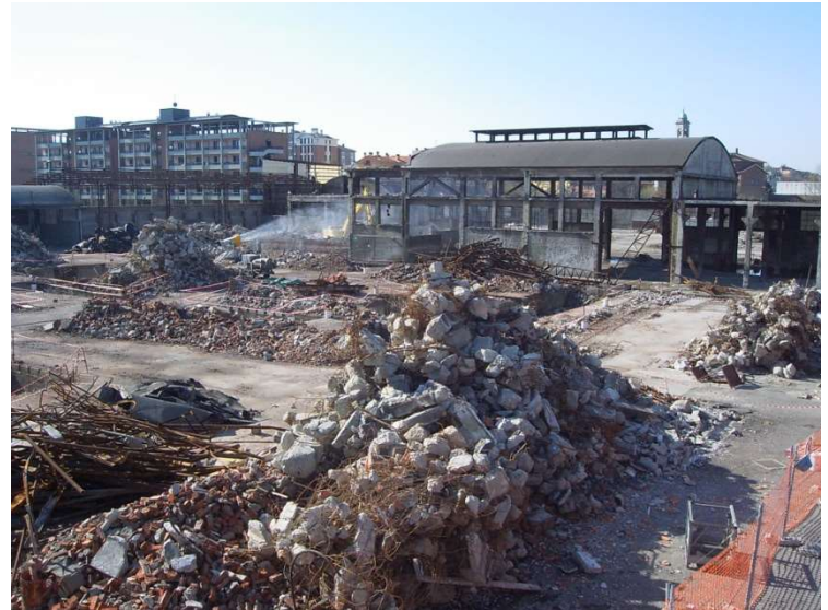
Cannone nebulizzatore per abbattimento polveri
