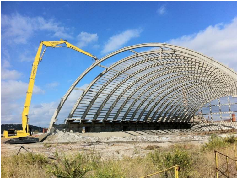
Fasi di demolizione
