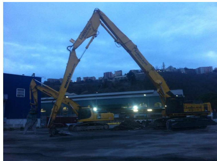
Escavatori cingolati utilizzati durante la demolizione
