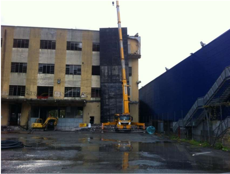
Imbragaggio mediante autogru
