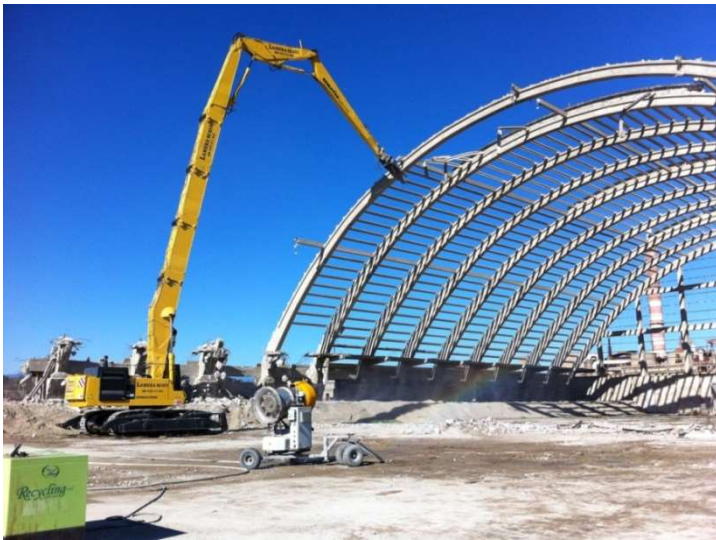
Escavatore PC 650 durante le fasi di demolizione
