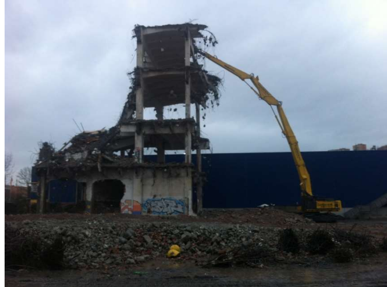
Demolizione avanzata dell'edificio ex mensa
