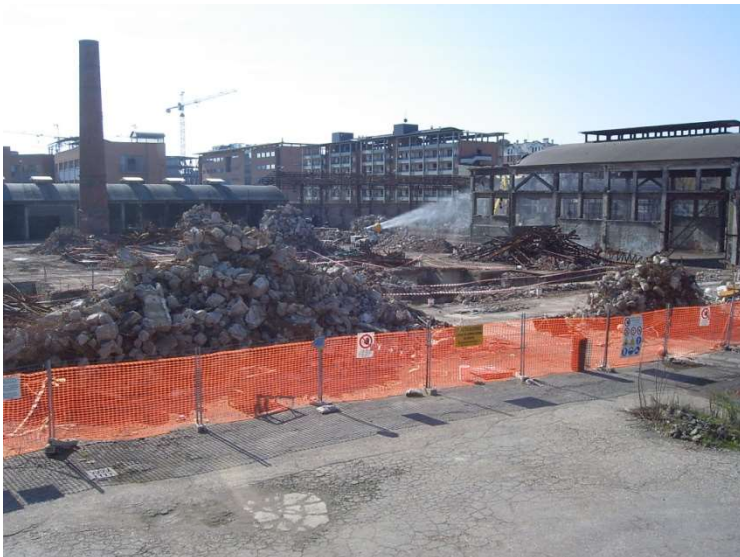
Particolare area d'intervento
