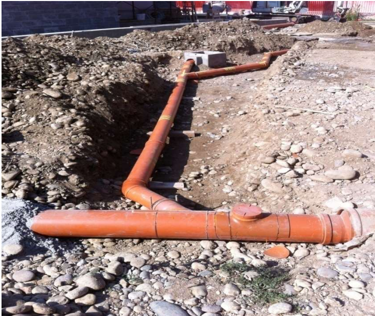
Collegamento fognari in pvc
