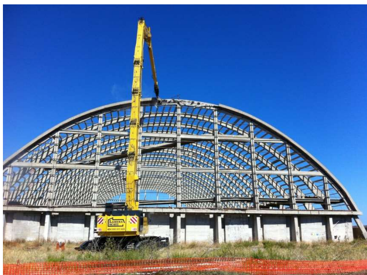
Demolizione di un capannone
