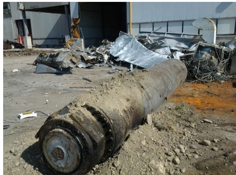
Particolare impianto industriale da cesoiare mediante taglio a freddo
