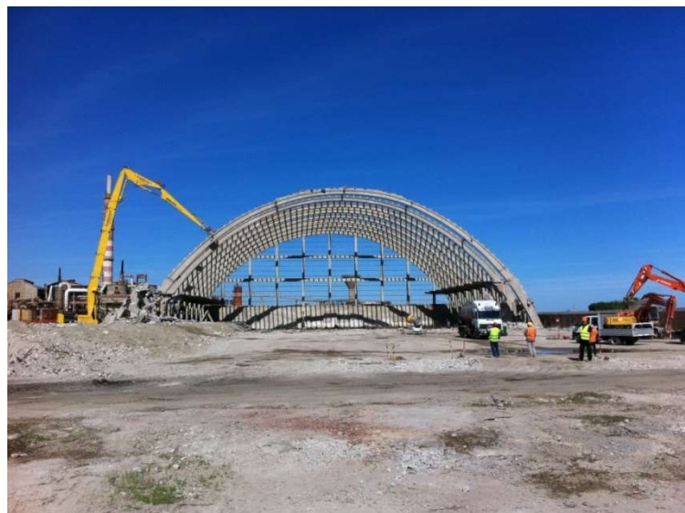
Veduta area cantiere
