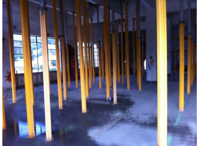
preventivo puntellamento interno dell'edificio
