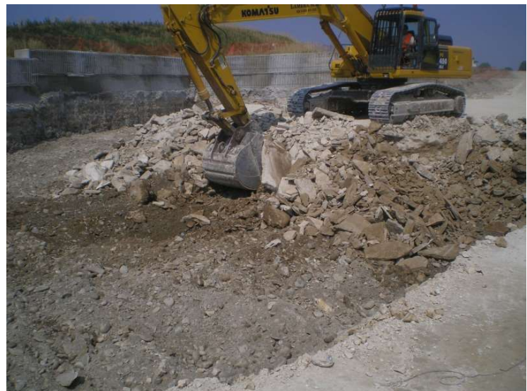
Escavatore con benna rovescia
