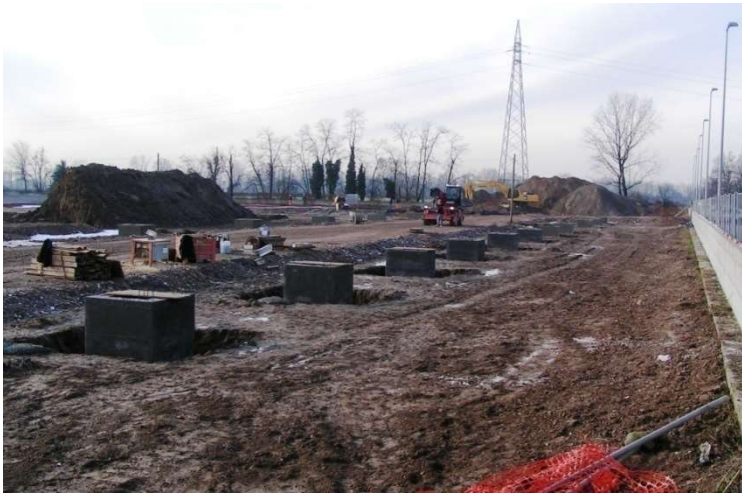
Movimenti terra e riporti di materiale riciclato certificato
