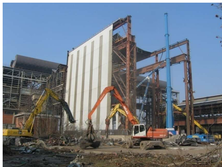
Demolizione capannone in ferro di 40mt
