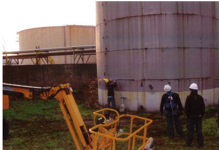
Fase di demolizione
