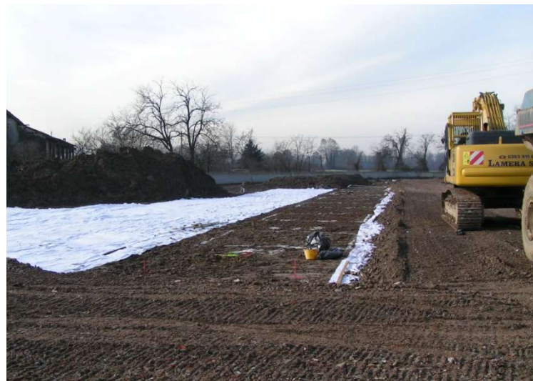
Posa di TNT e riporti di materiale riciclato certificato
