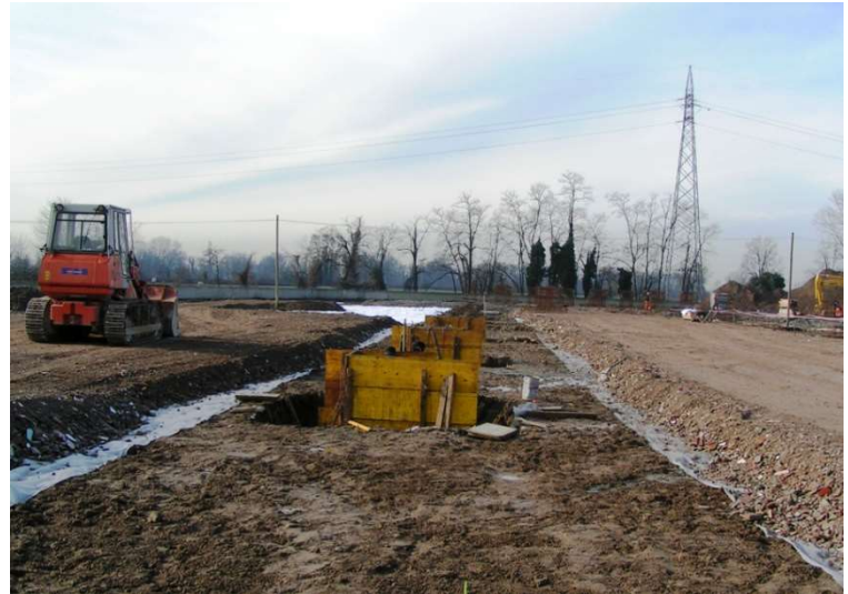
Movimenti terra e livellamenti
