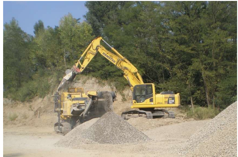
Fase dei lavori
