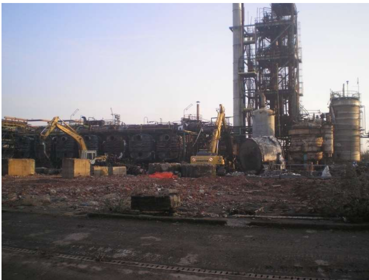
Demolizione impianto anidride maleica
