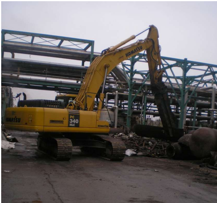
Escavatori cingolati con pinza idraulica
