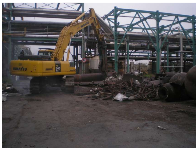
Escavatore utilizzato durante le opere di demolizione
