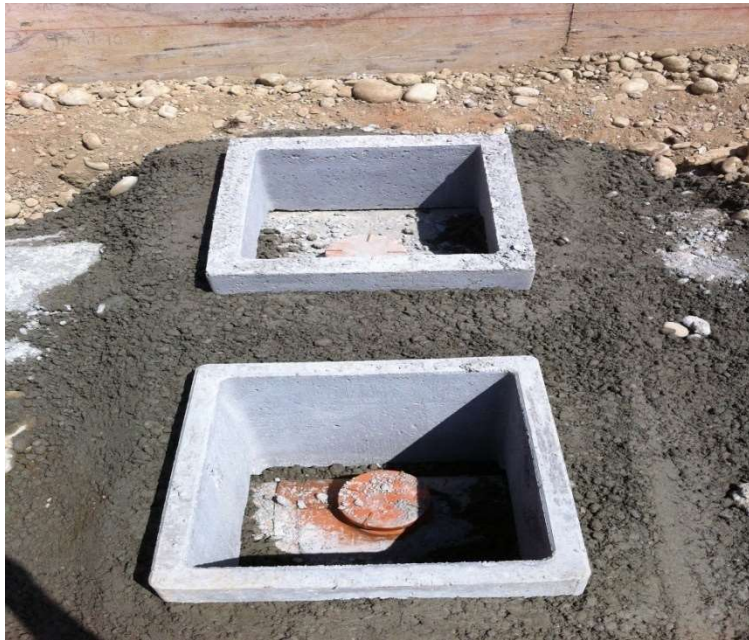
Particolari pozzetti di ispezione
