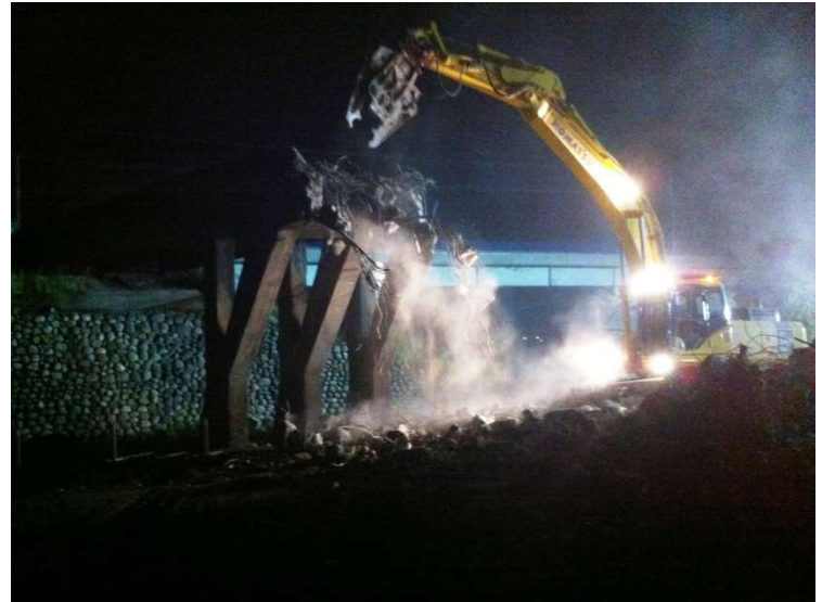
I lavori notturni
