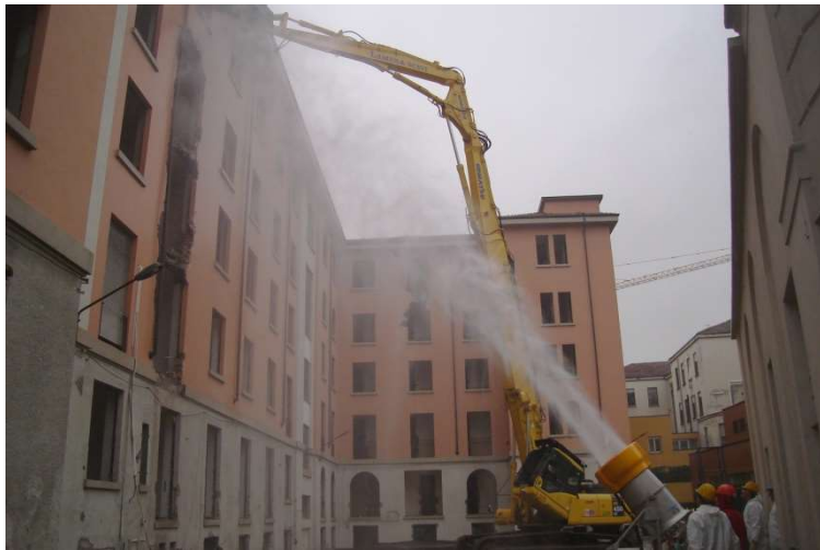
Escavatore con pinza idraulica in azione
