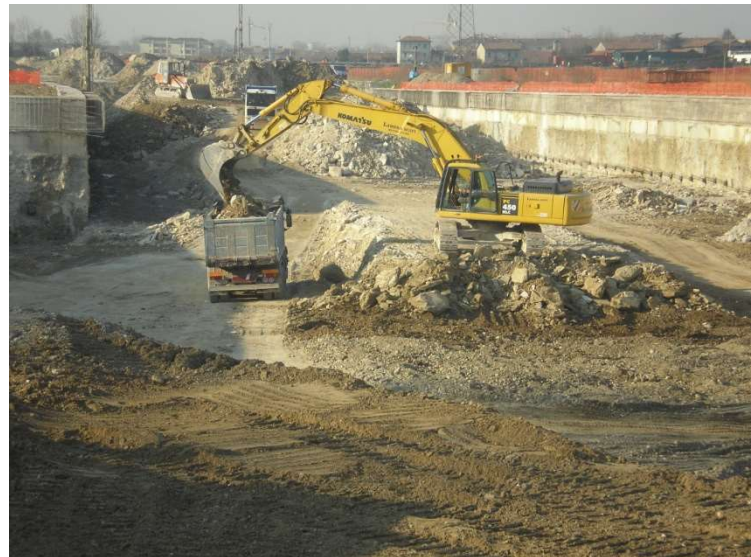
Escavatore con benna rovescia
