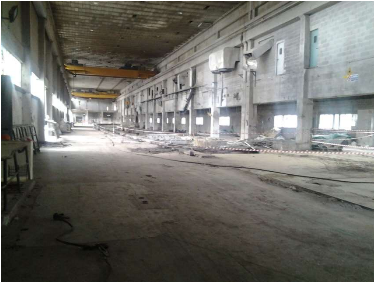
Veduta area interna
