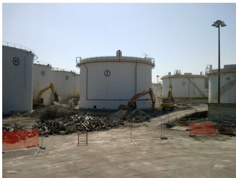
Escavatori durante i lavori
