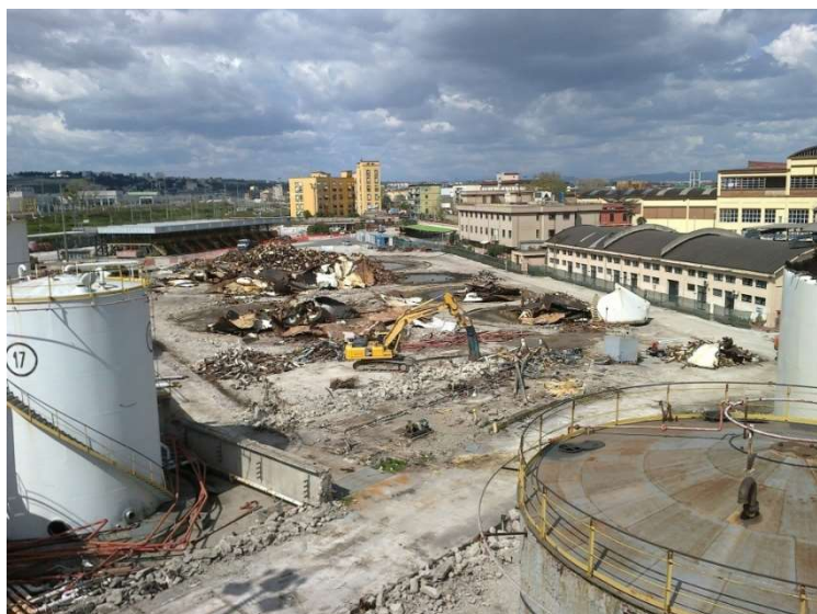
Vista aerea dell'area già demolita
