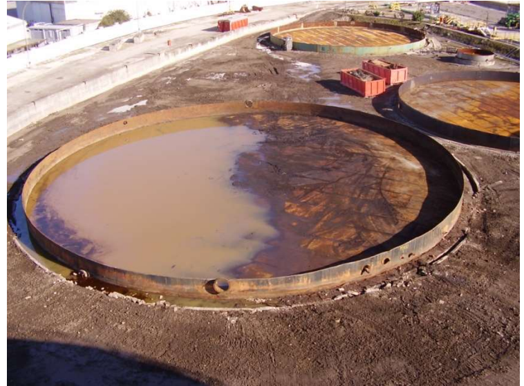
Cantiere post demolizione
