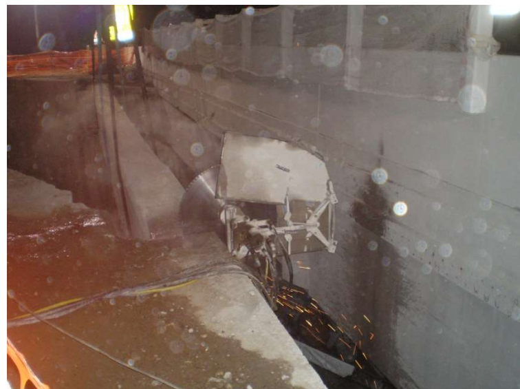
Utilizzo del disco diamantato
