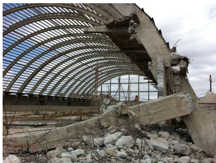
La struttura di cemento armato durante la demolizione
