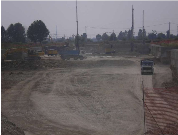
Veduta area cantiere
