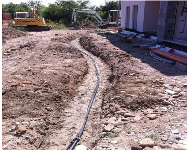
Posa di tubazioni HDPE
