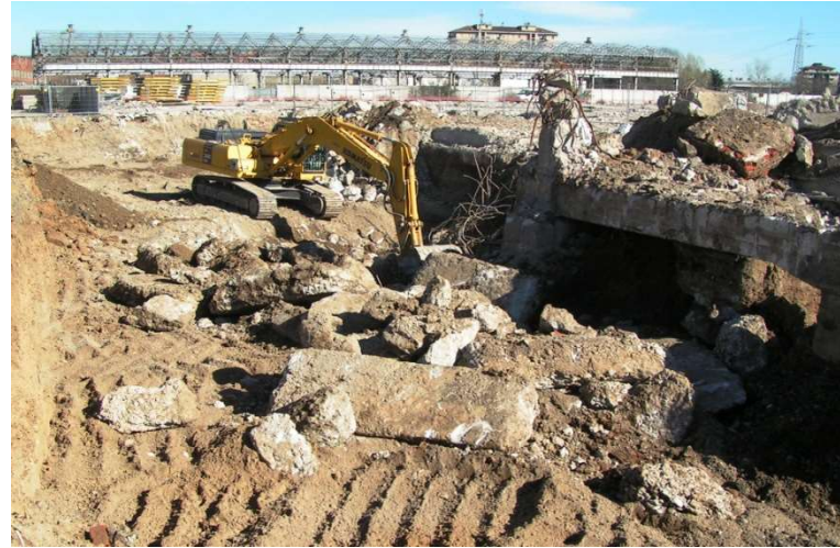
Demolizione area ex Ercole Marelli
