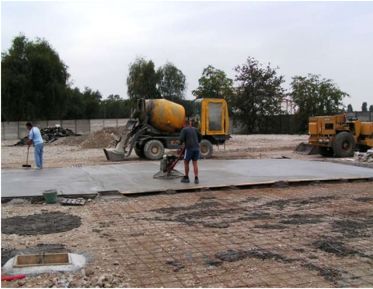
Operai durante i lavori
